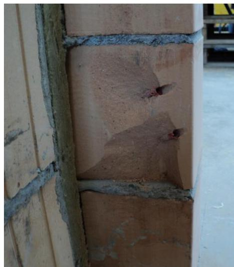
Weil unsere Vorgänger die Dübel zu wenig tief eingeschlagen haben, ist der Backstein abgesplittert. Die Reparatur eines solchen Mauersteines kostet etwa 500 CHF.
